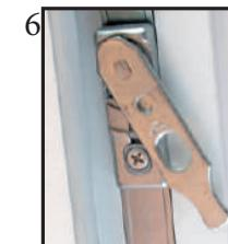
Système anti-fausse manœuvre et levier de vantail.
