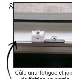
Câle anti-fatigue et jonc de finition en partie basse du dormant.
