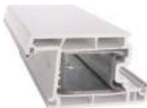
Nos portes d'entrée sont toutes renforcées d'armatures métalliques sur la totalité de la porte (ouvrant et dormant). De plus, les points d'ancrage et de fixation sont réalisés sur cette ossature qui assure une grande fiabilité à l'ensemble.
